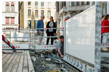
La posa delle barriere di protezione
