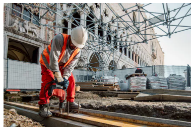
Realizzazione del fissaggio delle barriere
