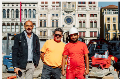
Il tecnico esperto di fischer in cantiere a Venezia
