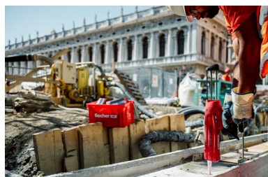
Estrusione della resina FIS EM Plus
